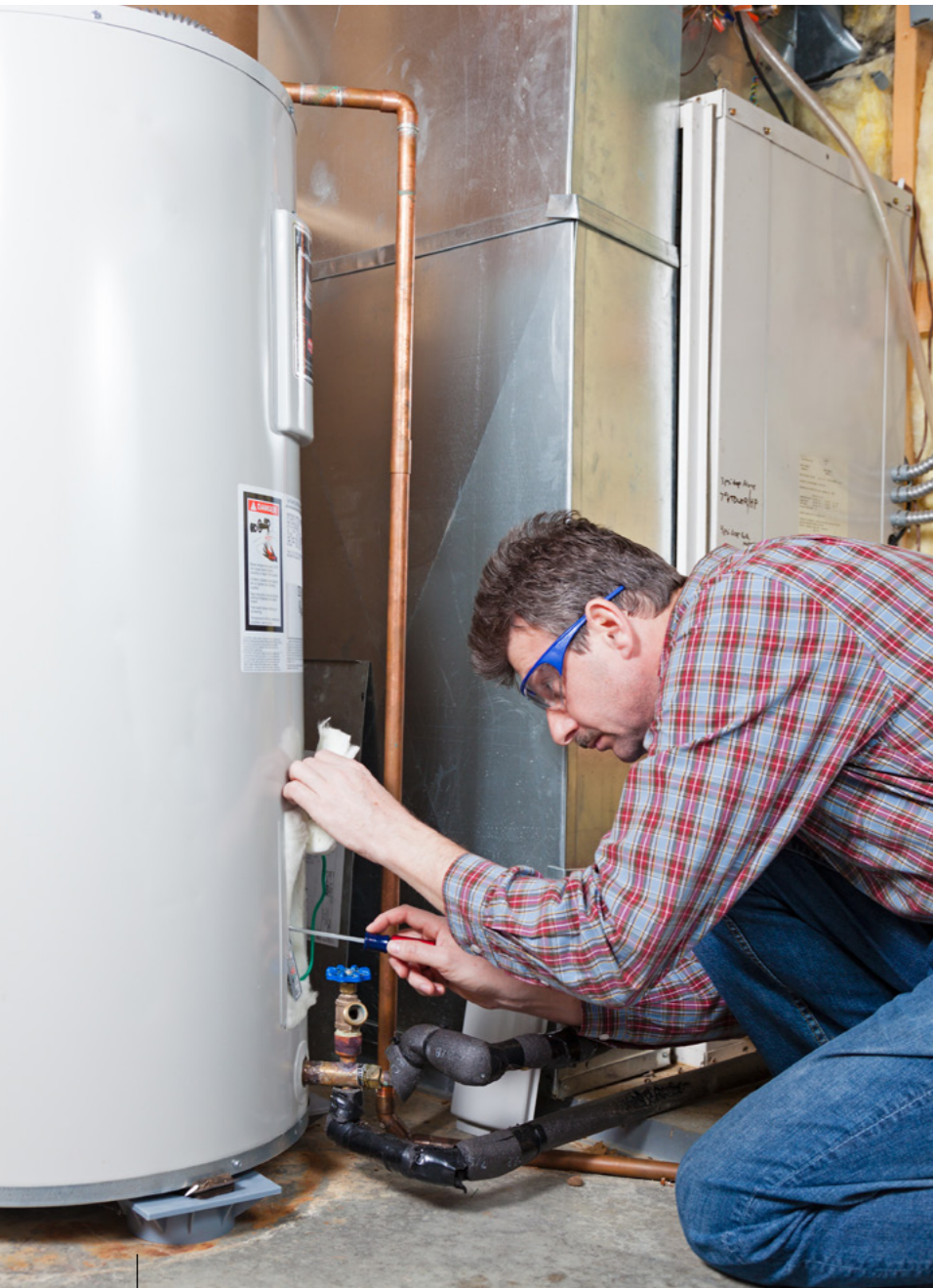
Foto 4: Drukverlies kan ook worden veroorzaakt door een verkeerde berekening van de boilerinhoud.
