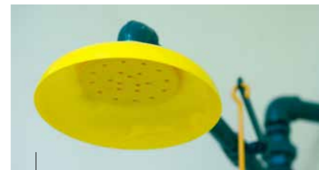
Foto 3: Nooddouches moeten worden aangesloten op de drinkwaterinstallatie.
